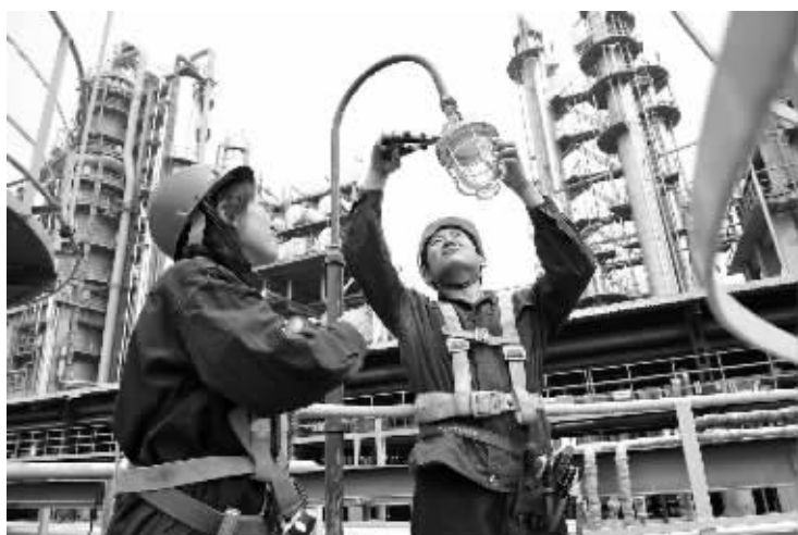
中原油田华苑公司应用先进的半导体照明、太阳能等技术,研制出多种适合石油石化行业高危险场所使用的LED防爆、太阳能等系列节能环保灯,具有耗电量小、安全、使用寿命长等优点,且较传统光源节能60%~70%。图为6月16日,中原油田华苑公司电子电器厂职工正在石油化工总厂安装LED防爆节能灯。(全江 摄)
